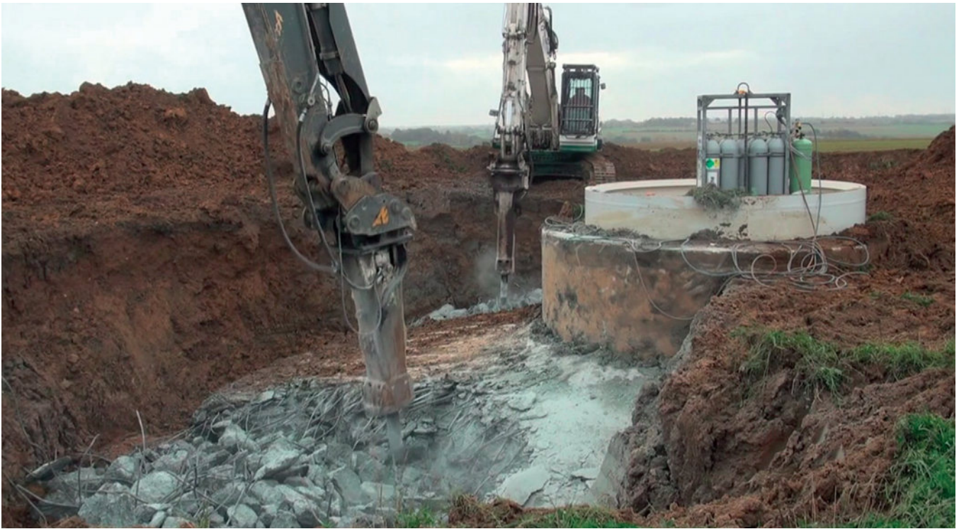
Photo 4 – Démantèlement d'une fondation d'éolienne à Criel-sur-Mer (76).
