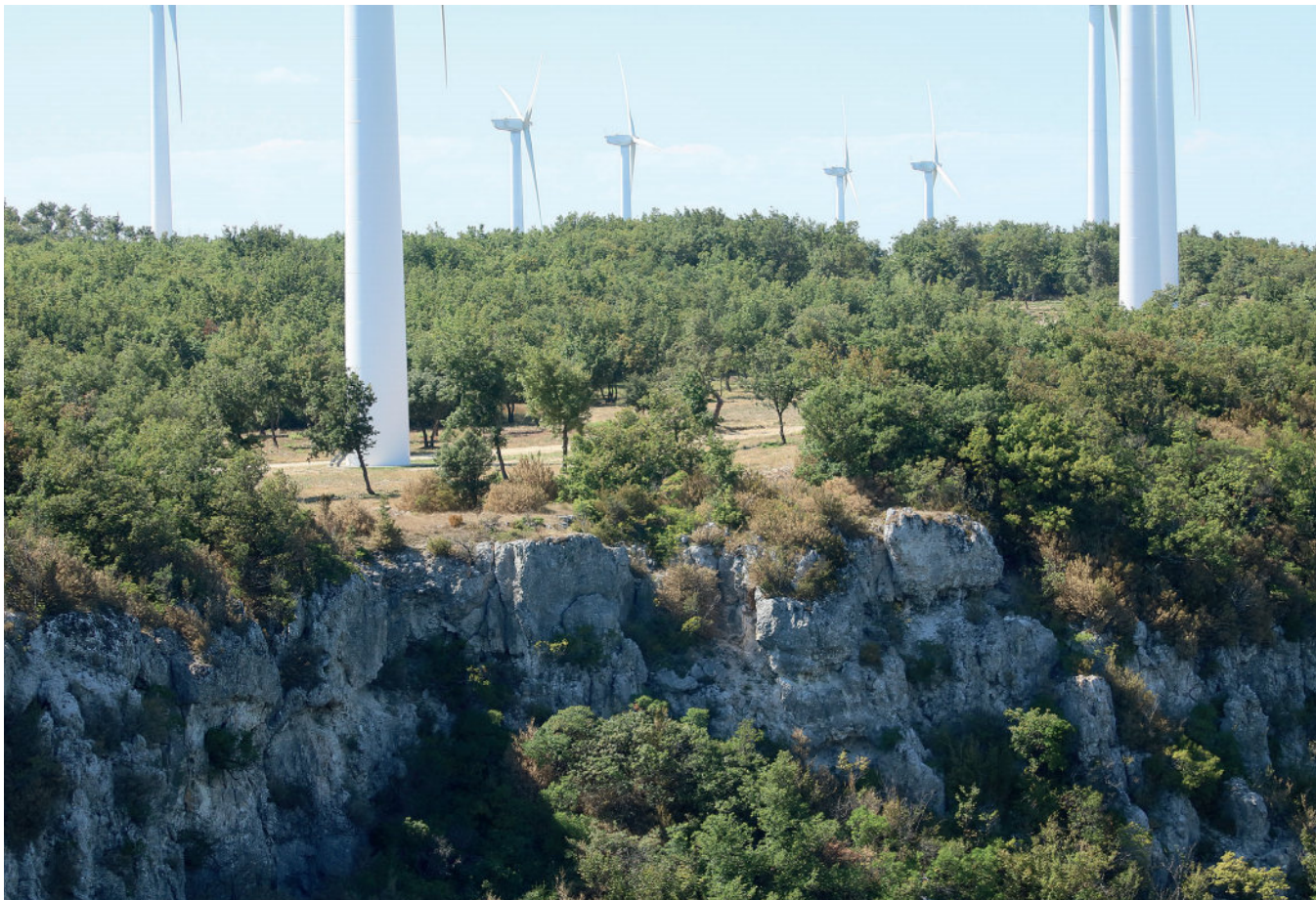
Photo 8 – Parc éolien dans la Drôme. L’installation d’éoliennes à proximité de falaises et de crêtes, où peuvent nicher rapaces diurnes et nocturnes, est à proscrire, surtout quand elles se situent face aux vents dominants.
