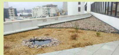
LPO 35 avec Poste Immo.
