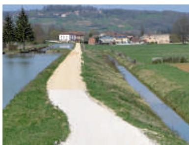
**Éléments minéraux compactés et perméables** : sable stabilisé / graviers de granulométries différentes. Le sable stabilisé est souvent choisi pour les espaces de circulation, car bien compacté et mélangé avec de la chaux, il assure une bonne surface de roulement avec portance tout en conservant sa capacité à infiltrer les eaux pluviales. Il est critiqué pour sa colonisation par l'herbe, nécessitant une communication spécifique auprès des usagers.
