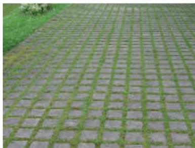
**Surfaces maçonnées perméables avec mixité minéral / végétal** : dalles / revêtements alvéolaires / pavés filtrants. Ce type d'éléments peut être posé avec des joints en terre, colonisés à terme par la végétation ou sans joints. Cet interstice permet l'infiltration de l'eau et génère le développement de micro-organismes ou tout simplement, d'une vie sous le revêtement.
