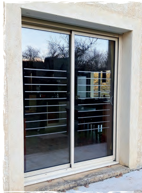
Exemple d'installation de vitrophanie sur les vitres de la maison (vue extérieure et intérieure). Après 2 ans d'utilisation, les propriétaires ont constaté une importante diminution du nombre de collisions d'oiseaux contre les vitres.
