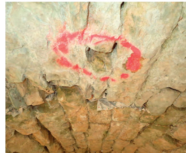
En prévision de travaux de rejointoiement au niveau d'un pont maçonné à Sèniargues, un disjoints particulièrement favorable aux chiroptères a été marqué pour être conservé en l'état.
