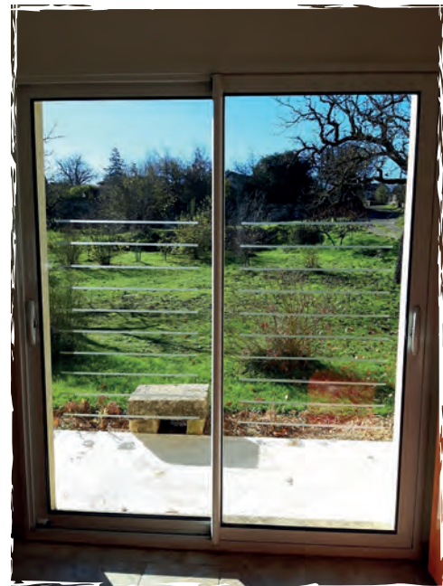
Exemple d'installation de vitrophanie sur les vitres de la maison (vue extérieure et intérieure). Après 2 ans d'utilisation, les propriétaires ont constaté une importante diminution du nombre de collisions d'oiseaux contre les vitres.
