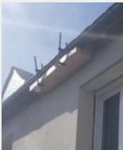
Il s'agit d'un caisson en bois à 4 ou 3 faces selon la position du nid (sous le toit ou dans un angle). Si la hauteur des nids est importante, les caissons peuvent être installés à partir de la toiture via des serre-joints directement au niveau de la gouttière.
