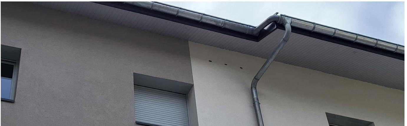
Nichour triple à martinets intégré dans l'isolant sur le site pilote de Grand Aigueblanche (73) © Ilan Badaoui
