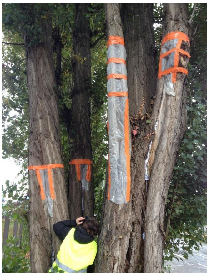
Dispositif apposé sur des fissures, la veille de l'abattage, pour empêcher le retour des chauves-souris dans leur gîte.
