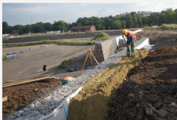
Aménagement de poches de sable contre un mur de soutènement © Yohan Tison
