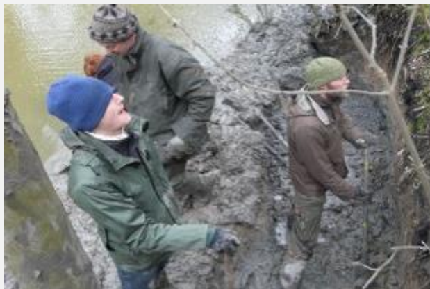
Chantier de création de micro-falaises en bord de cours d'eau © Yohan Tison
