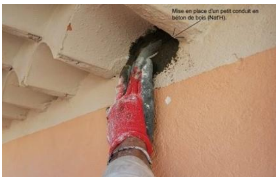
Mettre en place un conduit préfabriqué d'accès à la cavité. © Raffaello
