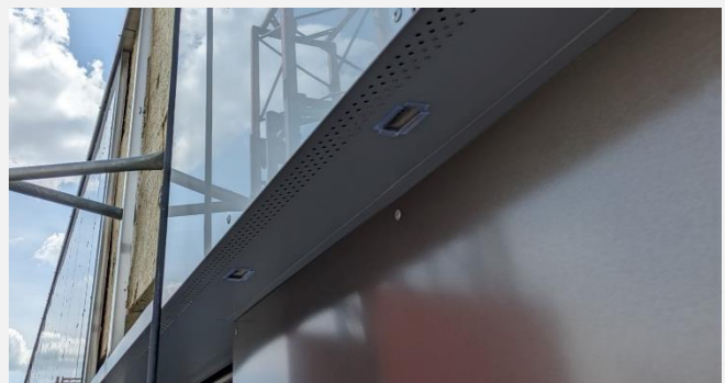
Trous d'envol visibles en sous face de l'épaisseur du bardage © LPO - IdF
