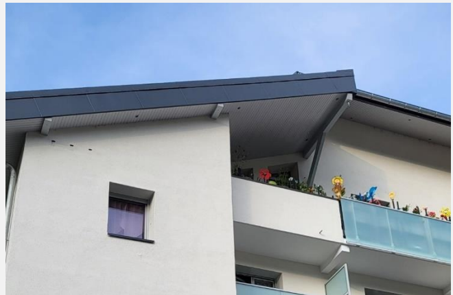
Une fois le nichoir triple encastré et la façade enduite, les trous d'envol sont peu visibles.
