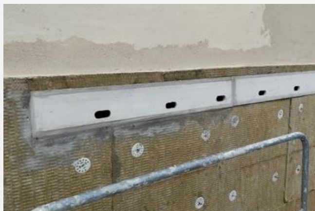
Intégration de nichoirs triples à Martinets noirs dans l'ITE
