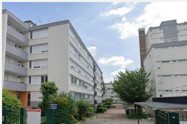
Après les travaux de rénovation
