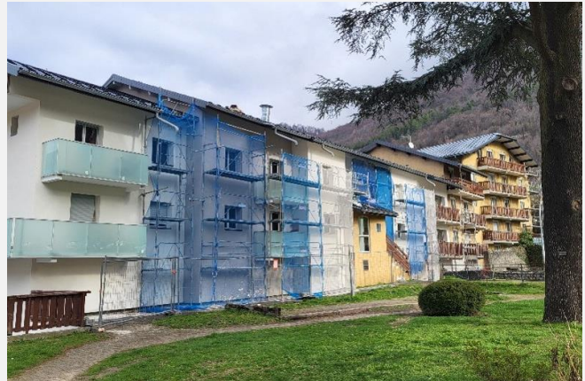
Réduction de la hauteur des échafaudages et pose de filets de protection.
